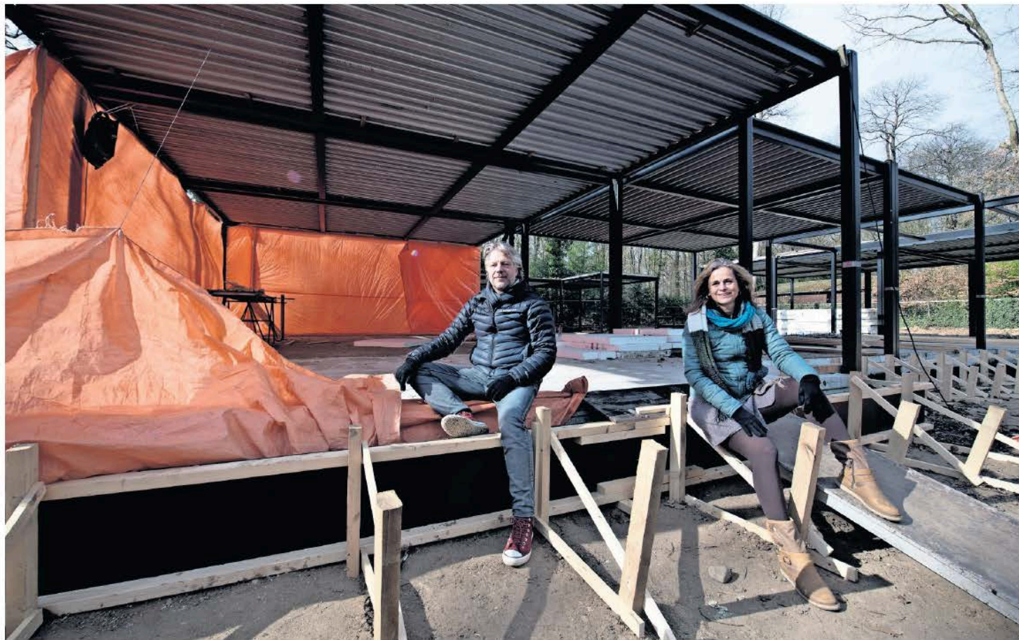
▲ Perry Elbers en Angèle van de Ven bij hun project in aanbouw. FOTO PAUL RAPP
